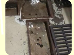
厨房 側溝清掃→P.8
